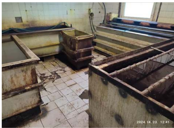
Fémmegmunkáló savazó helyiség botlásveszélyes padlóburkolat, a veszélyes anyag elhelyezésére alkalmatlan korrodálódott kádakkal.
