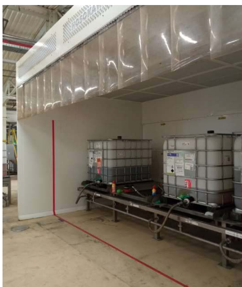
A veszélyes anyag vételezése során a tároló hely megközelítésekor a zónába lépve az elszívó berendezés is és a világítás is bekapcsol.
