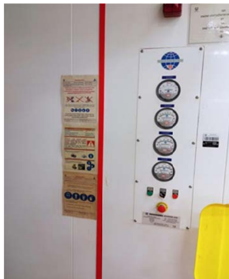
A veszélyes anyag vételezése során a tároló hely megközelítésekor a zónába lépve az elszívó berendezés is és a világítás is bekapcsol.
